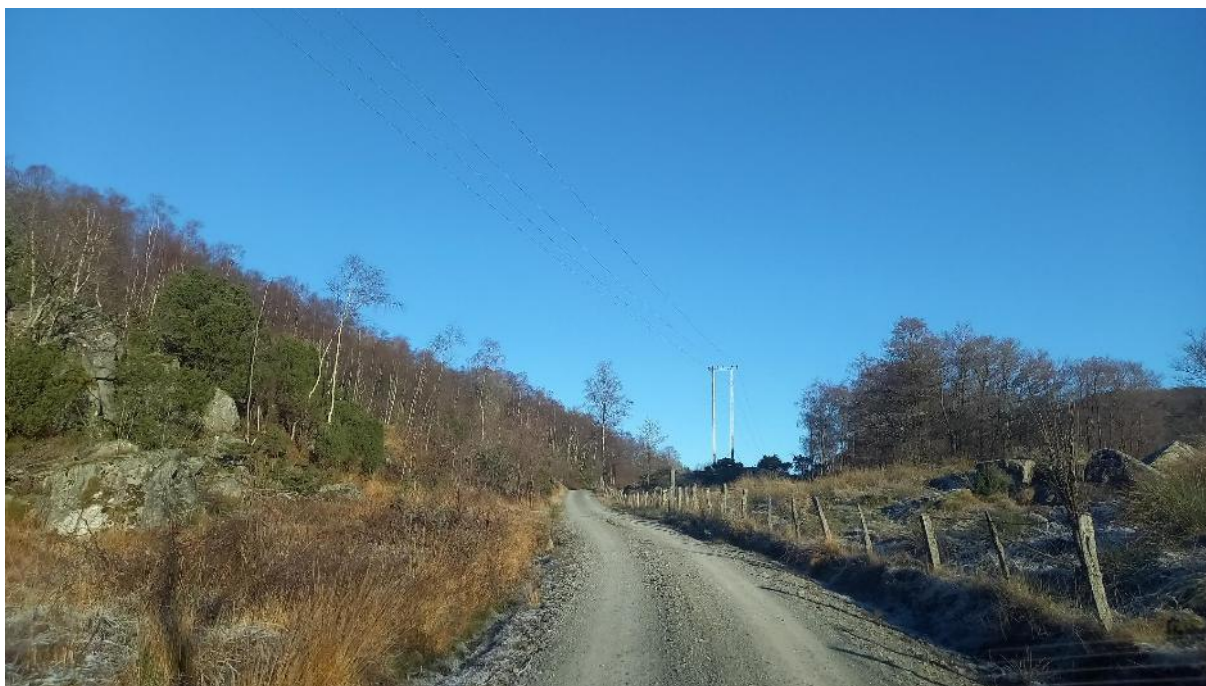
Figur 5.3. Ferdselsåren Kvamaheivegen der en 22 kV kraftledning krysser turruten.
